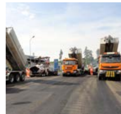
5 Belagseinbau am gleichen Tag
