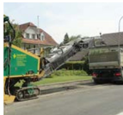
1 Vorbereitung des Traggrundes durch Fräsen und/oder Nassreinigung
