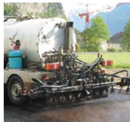
2 Aufbringen der Bitumenemulsion auf trockenem und sauberem Traggrund
