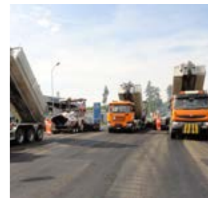
5 Belagseinbau am gleichen Tag
