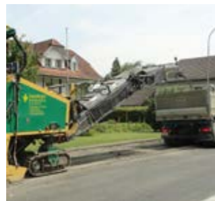
1 Vorbereitung des Traggrundes durch Fräsen und/oder Nassreinigung
