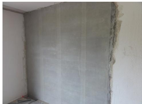
Bild 54: Wandverstärkung mit S&P G-Sheet
