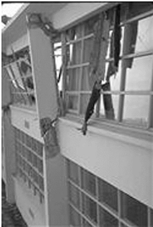
Bild 56: Schwach ausgebildeter Knotenpunkt
