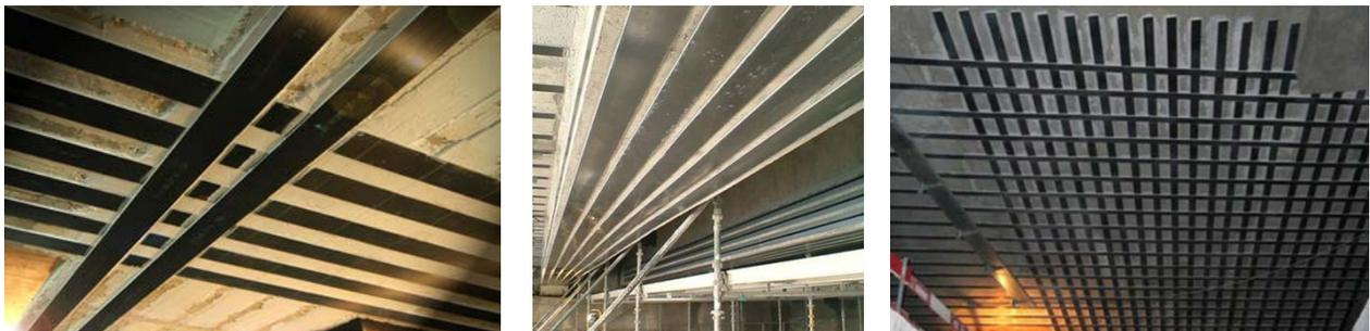
Bilder 10 / 11 / 12: oberflächlich geklebte Lamellen
