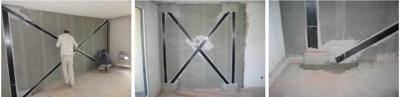
*Bilder 38 / 39 / 40: Verstärkung Mauerwerk (Erdbeben) mit S&P CFK-Lamellen mit Verankerung in Betondecke*
