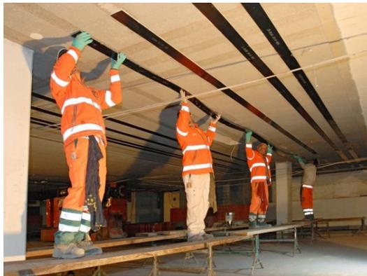
Bild 8: Einbau einer S&P CFK-Lamelle
