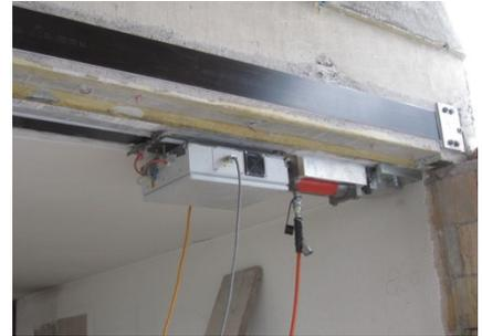
Bilder 26 / 27: Patentiertes S&P Vorspannsystem aus Aluminium
