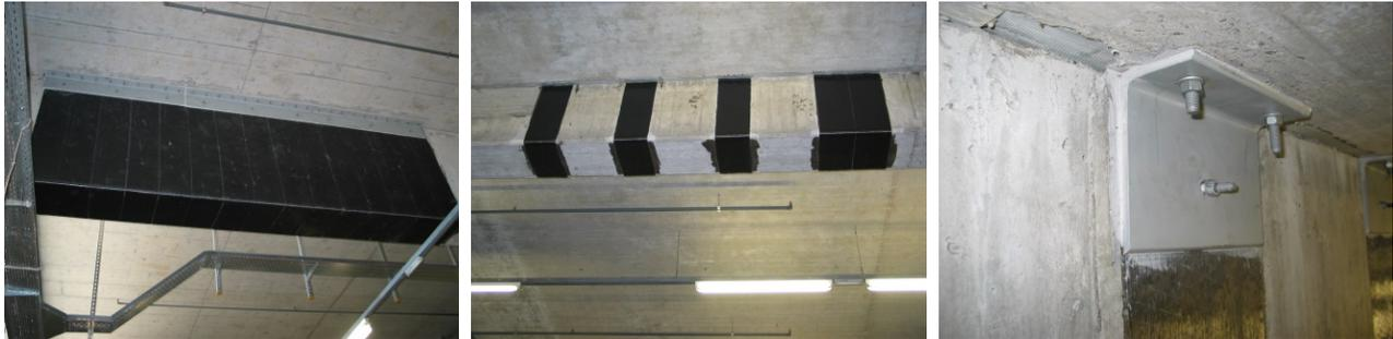
Bilder 42 / 43 / 44: Verstärkung Stahlbetonträger mit S&P C-Sheet 640 vollflächig oder punktuell (Fachwerkanalogie) mit Verankerung in die Druckzone
