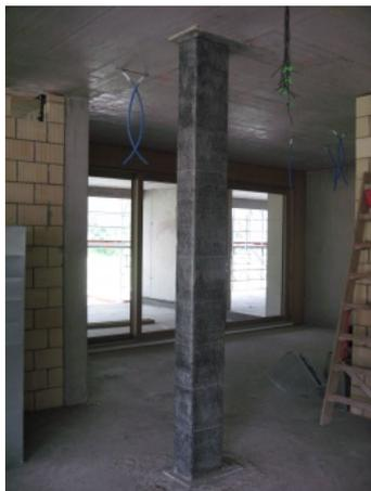
Bilder 52 / 53: Stützenumwicklungen mit S&P C-Sheet
