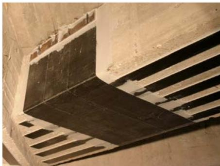
Bilder 18 / 19: endverankerte Lamellen an Decke oder Unterzug
