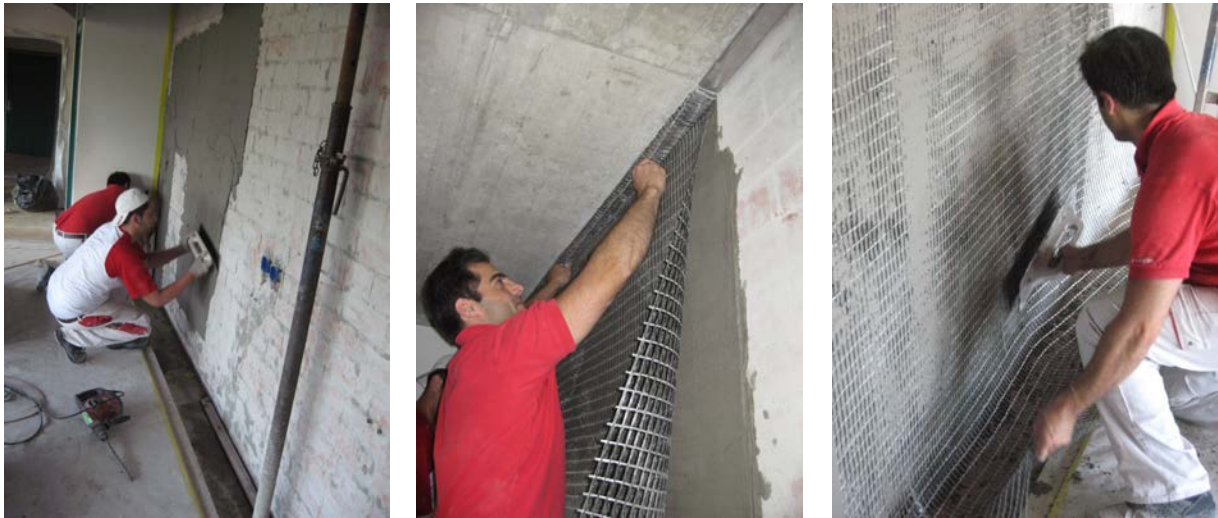
Bilder 26 / 27 / 28: seismische Verstärkung sowie Verankerung eines Mauerwerks mit S&P ARMO-mesh
