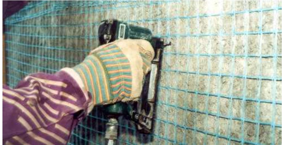
Bild 14: Fixierung mit Haftklammern
