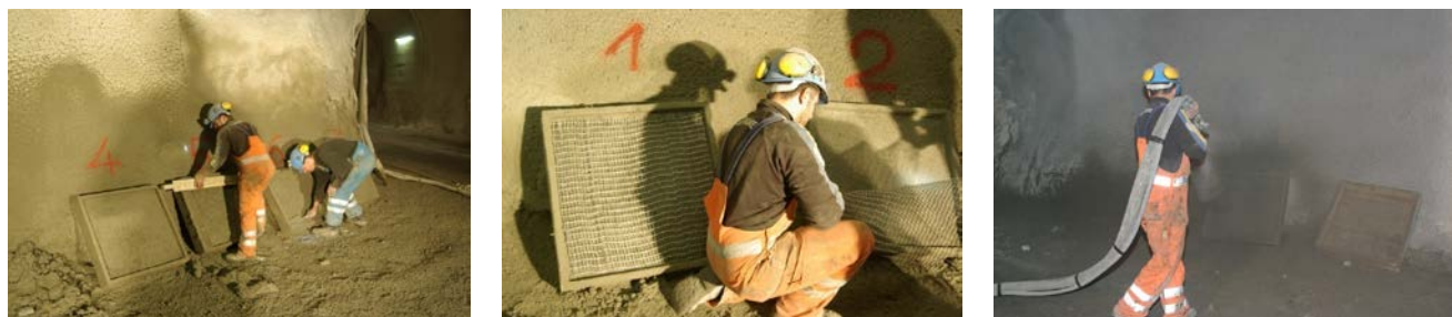
Bilder 17 / 18 / 19: Applikation der Probekörper für Arbeitsvermögen
