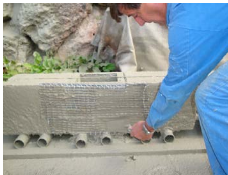
Bild 4: Applikation von Spritzmörtel und S&P ARMO-mesh L500
