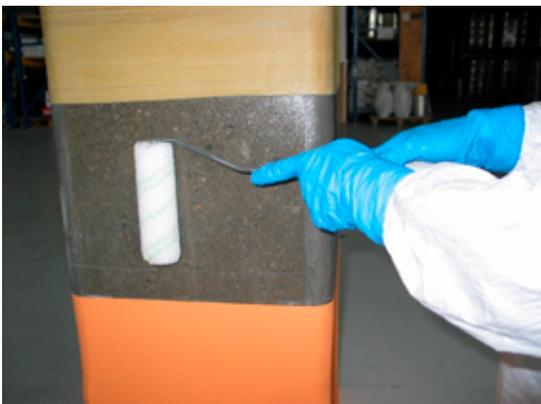
Auftragen von S&P Resicem HP (dampffoffen) oder S&P Resin 55 HP (dampfdicht) auf den vorbereiteten Untergrund.
