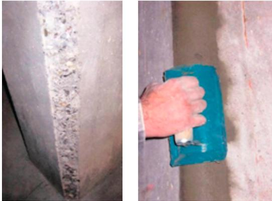
Abrunden von allfälligen Ecken und Kanten im Radius von mindestens 10 mm (Schleifen oder Reprofilieren).
