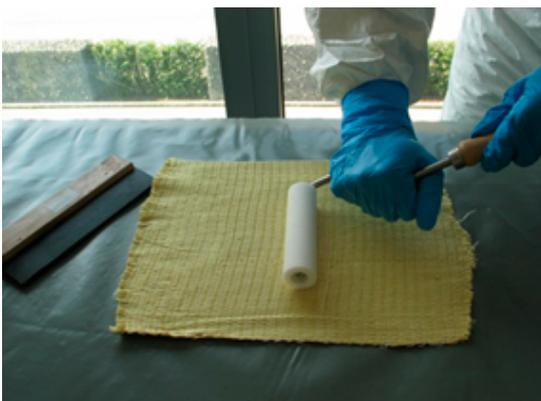
S&P A-Sheet 120 mit S&P Resicem HP bzw. S&P Resin 55 HP vorimprägnieren.
