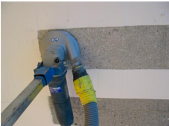
Untergrund Sandstrahlen, Kugelstrahlen oder Schleifen mit Diamanttopfscheibe.
