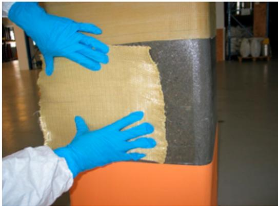
Das vorimprägnierte S&P A-Sheet 120 am Untergrund fixieren, die Schutzfolie entfernen und mit Gummispachtel (Squeeze) oder gerilltem Anpressroller einlaminierten.
