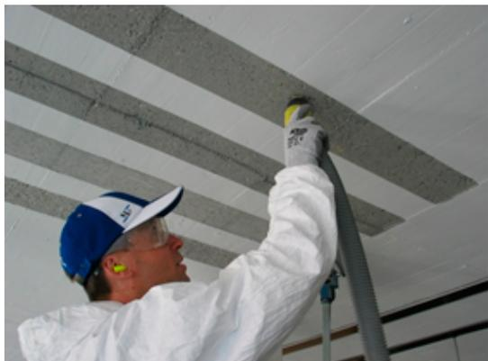
Reinigen des Untergrundes mit Absaughilfe.
