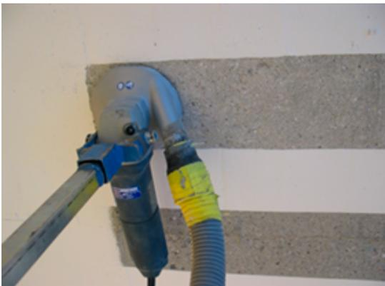
Untergrund Sandstrahlen, Kugelstrahlen oder Schleifen mit Diamanttopfscheibe.
