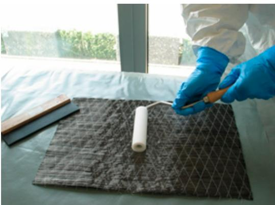
S&P C-Sheet 240 mit S&P Resicem bzw. S&P Resin 55 vorimprägnieren.
