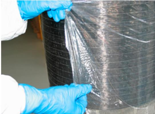
Das vorimprägnierte S&P C-Sheet 240 am Untergrund fixieren, die Schutzfolie entfernen und mit Gummispachtel (Squeeze) oder gerilltem Anpressroller einlaminieren.
