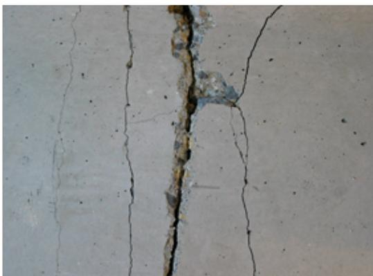
Entfernen von schlechtem Beton (Kiesnester), Überbeton (Graten), losen Teilen, Holzrückständen, Isolationsmaterial oder dergleichen.
