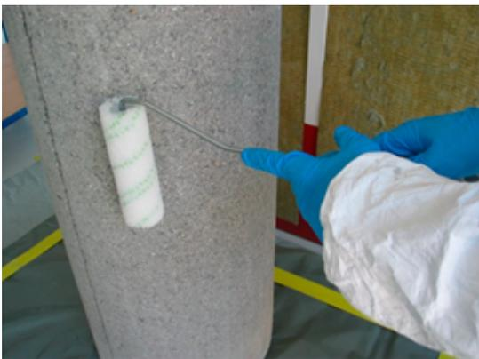
Auftragen von S&P Resicem (dampffoffen) oder S&P Resin 55 (dampfdicht) auf den vorbereiteten Untergrund.
