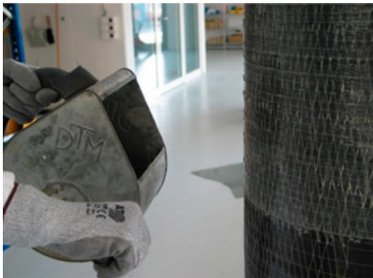
Abstreuen mit feuergetrocknetem Quarzsand (z.B. Körnung 0,7 – 1,2 mm) als Haftbrücke für späteren Verputz, Mörtel oder Beschichtung im gleichen Arbeitsgang.
