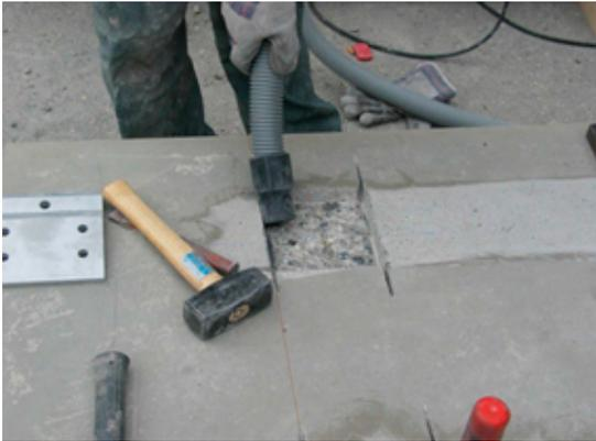
Der Staub im Bereich der Aussparung muss vor Beginn der Versetzarbeiten in jedem Fall entfernt werden (Industrieabsaughilfe).
