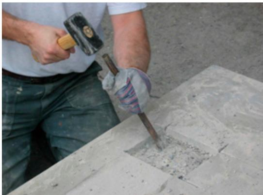
Entfernen des Betons im Bereich der Aussparung.
