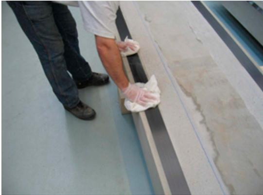
S&P C-Lamine (oberflächlich geklebt) und die Deckplatte der Endverankerung werden mit dem S&P Cleaner kleberseitig sauber gereinigt und entfettet.
