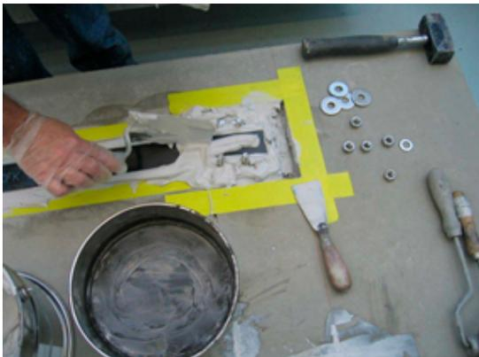
Die CFK Lamelle wird fachgerecht am Untergrund verklebt und der S&P Epoxidharzkleber Resin 220 wird am Verankerungsende aufgetragen.
