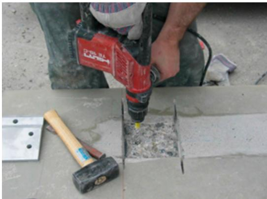
Bohren und Versetzen des Ankers (12 mm).
