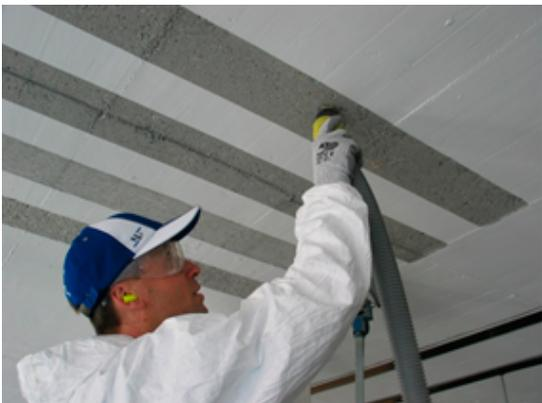
Reinigen des Untergrundes mit Absaughilfe.
