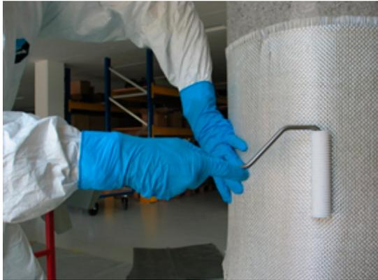
Den Anpressroller oder die Gummispachtel nur in Faserrichtung ziehen bis alle Fasern vollständig benetzt und keine Lufteinschlüsse vorhanden sind.
