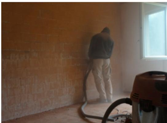
Untergrund Sandstrahlen, Kugelstrahlen oder Schleifen mit Diamanttopfscheibe.
