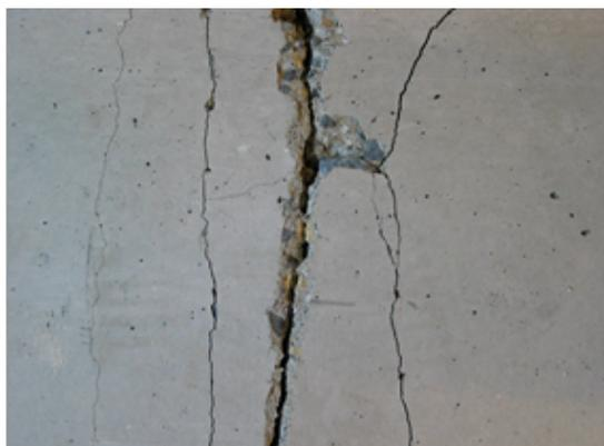
Entfernen von schlechtem Beton (Kiesnester), Überbeton (Graten), losen Teilen, Holzurückständen, Isolationsmaterial oder dergleichen.
