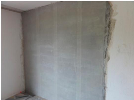
Ansicht der fertigen Applikation eines Wandpfeilers. Volle Tragfähigkeit bei 23 °C und 50 % Luftfeuchtigkeit nach ca. 72 Stunden.
