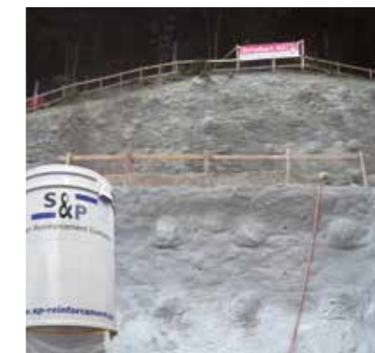
5 Tiefbau (Baugrubensicherung, Stützmauern)
