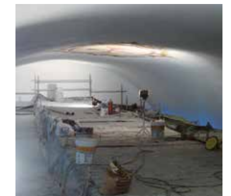
6 Historische Bauten (Mauerwerksverstärkung)
