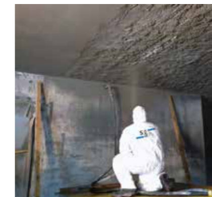
4 Hochbau (Erdbebensicherung, Stützenverstärkungen)
