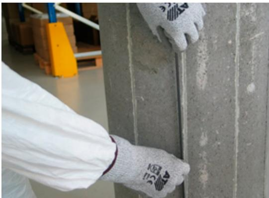
Einlegen der S&P C-Laminate (eingeschlitzt)
