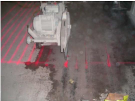
Fräsen der Schlitzte (trocken oder nass).
