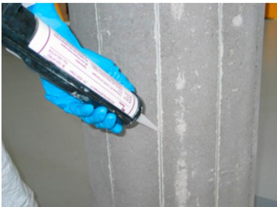
Gleichmäßiges Verfüllen der Schlitze mit S&P Resin 220.
