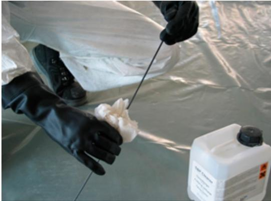
Reinigen und Entfetten der S&P C-Laminate (eingeschlitzt) auf beiden Seiten mit sauberem Tuch und S&P Cleaner.
