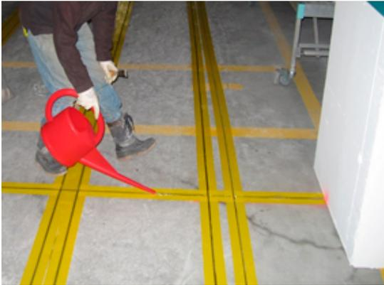
Bei **horizontalen** Bauteilen können die Schlitzte auch mit S&P Resin 55 HP verfüllt werden.
