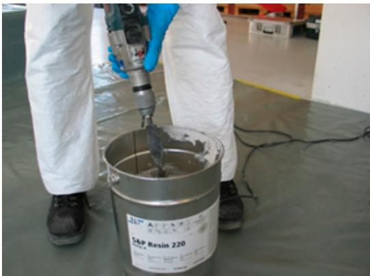
Mischen des Klebers S&P Resin 220 (S&P Resin 55 HP)
