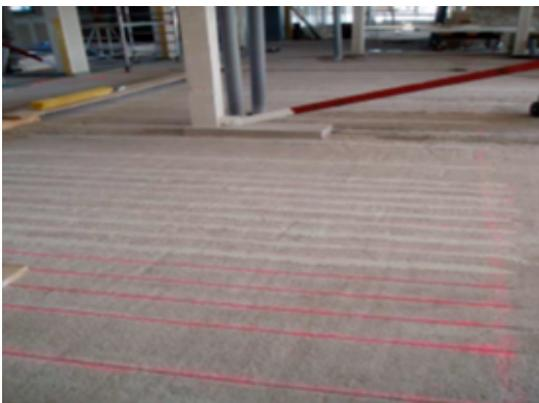
Ansicht der fertigen Applikation einer Deckenoberseite. Volle Tragfähigkeit bei 23 °C und 50 % Luftfeuchtigkeit nach ca. 72 Stunden.
