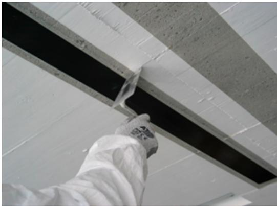
Entfernen des überschüssigen Klebers entlang der Lamellenkante.
