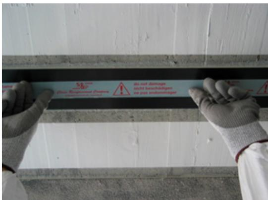
Aufkleben des S&P Warnbandes oder Kenntlichmachung der statischen Verstärkung zum Schutz vor mechanischer Beschädigung.
