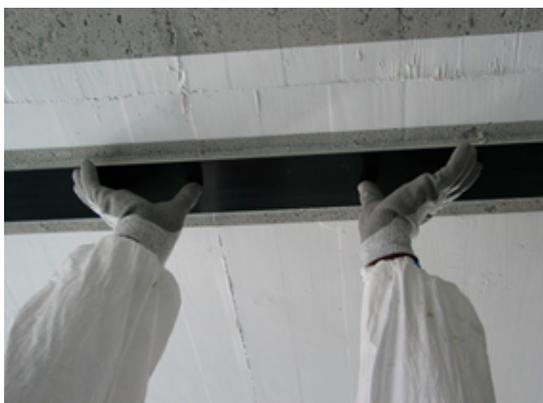
S&P C-Laminate von Hand positionieren,
