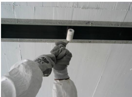
Gleichmäßiges Anpressen der Lamelle mit S&P
