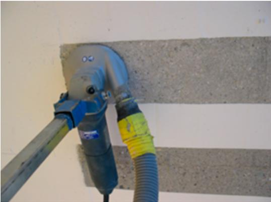
Untergrund Sandstrahlen, Kugelstrahlen oder Schleifen mit Diamanttopfscheibe.
