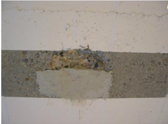
Reprofilieren mit S&P Resin 230 (Epoxydharzbasis) oder Instandsetzungsmörtel mind. R3 (mineralisch – Achtung Restfeuchtigkeit!).
