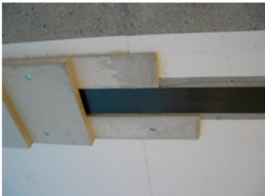
Ansicht der fertigen Applikation einer Deckenunterseite inkl. Brandschutzplatten (z.B. Promatect®-H).
